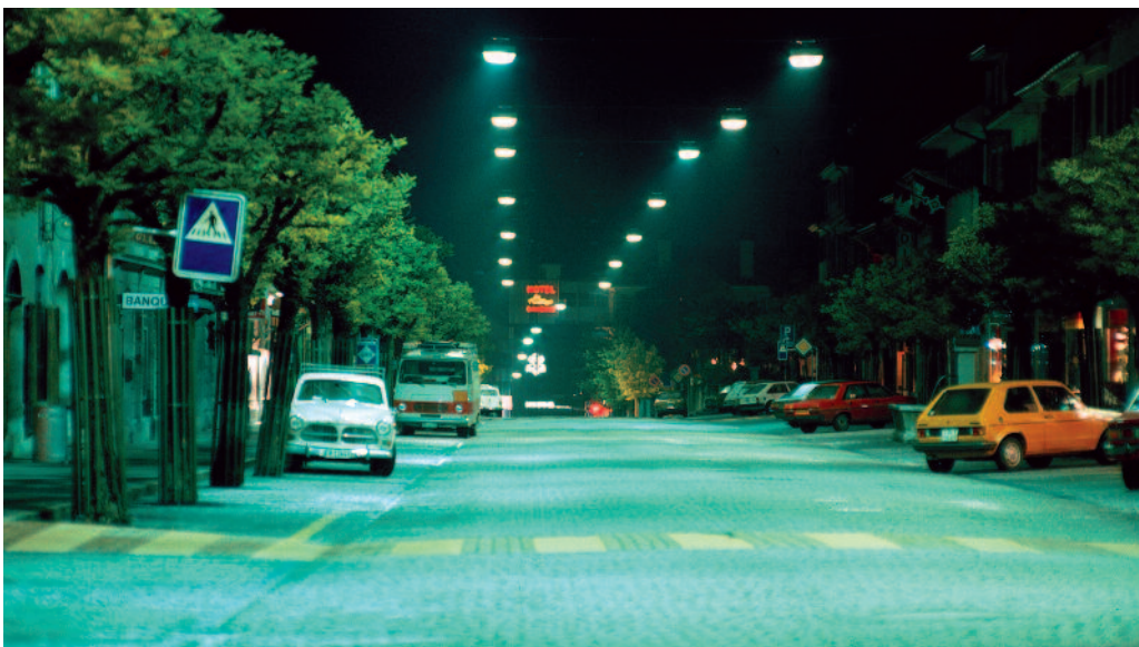
Abb. 5: Blendfreie Straßenbeleuchtung, die eine gleichmäßige und genügend hohe Leuchtdichte auf der Fahrbahn erzeugt.
