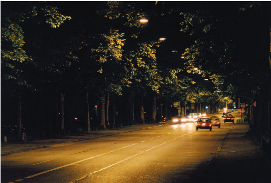
Abb. 7: Die Gleichmäßigkeit der Leuchtdichte, längs und quer zur Fahrtrichtung, ist gut.
