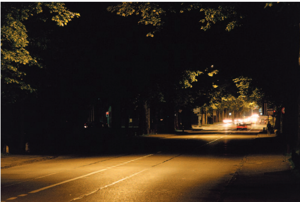
Abb. 8: Durch Abschalten einzelner Leuchten entsteht eine verkehrsgefährdende Längsungleichmäßigkeit der Leuchtdichte.
