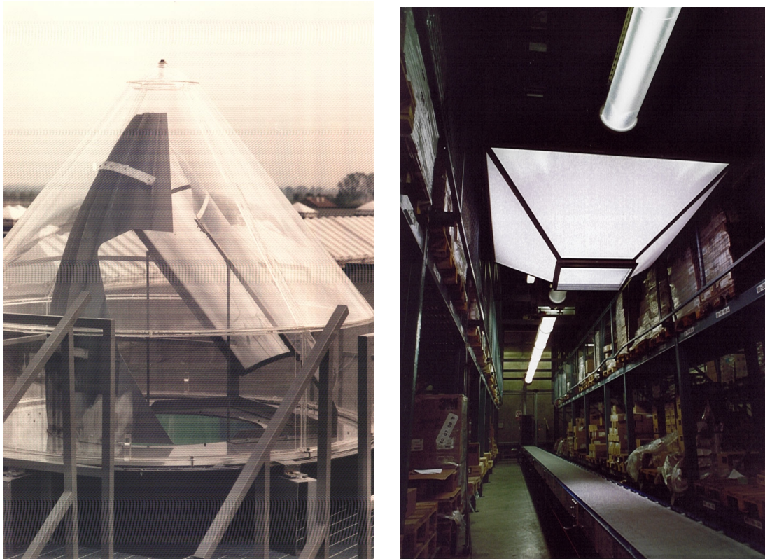
Abb. 5 Der Heliostat (links) und die Auskopplungseinheit (rechts) des italienischen ARHELIO-Prototypen bei 3M
