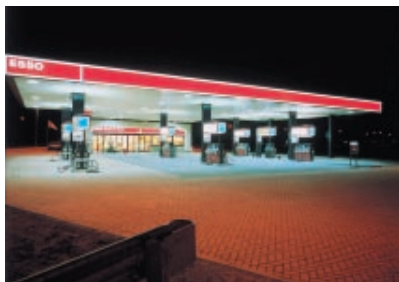
Abb. 1: HPI-Lampen von Philips im Einsatz an ESSO-Tankstellen.
