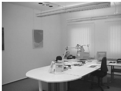
Abb. 5: Beleuchtungssituation „Kombination aus Direkt- und Indirektbeleuchtung“
