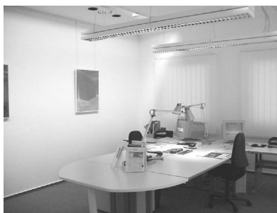
Abb. 9: Beleuchtungssituation „Kombination aus lokaler und Wandbeleuchtung“
