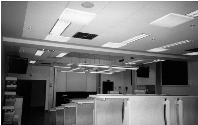
Bild 2: Demonstrationsraum im Bildungszentrum der Fleischerei Berufsgenossenschaft Reinhardtbrunn (Thüringen) mit Ein- und Anbauleuchten für verschiedene Demonstrationen
