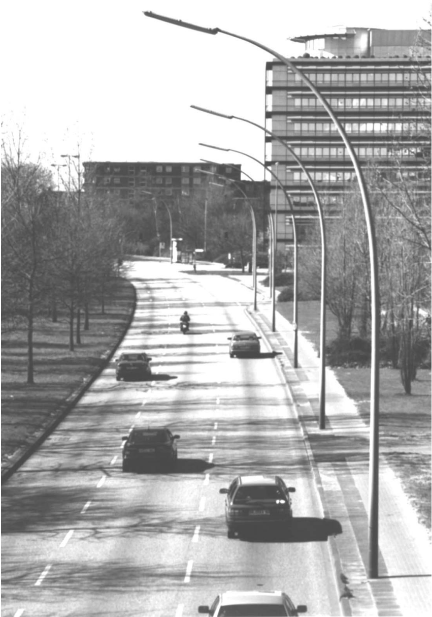
Abb. 7: Straßenbeleuchtung mit Leuchtstofflampen
