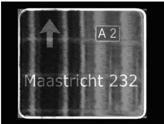
Abb. 9: Beispiel eines Wegweisers mit Taubildung auf der Oberfläche.
