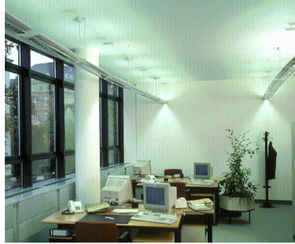
Abb. 2: Die zwei Beleuchtungssituationen zeigen die eingeschränkte Flexibilität herkömmlicher Leuchten. Dies verursacht weiterhin, daß das Erscheinungsbild eines Büroraumes mit Bildschirmarbeitsplätzen fast überall das gleiche ist.
