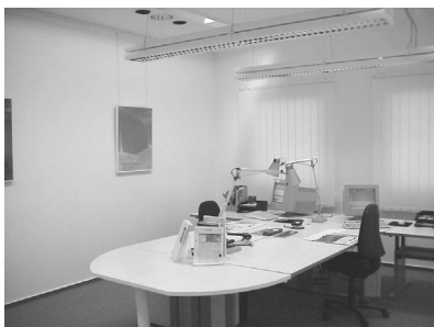
Abb. 6: Beleuchtungssituation „Kombination aus Direkt- und Wandbeleuchtung“
